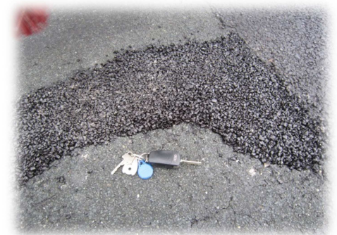
Eingebauter und verdichteter COMPOMAC ®
