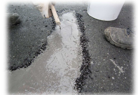
Vermörtelung mit DEUPHALT ®
